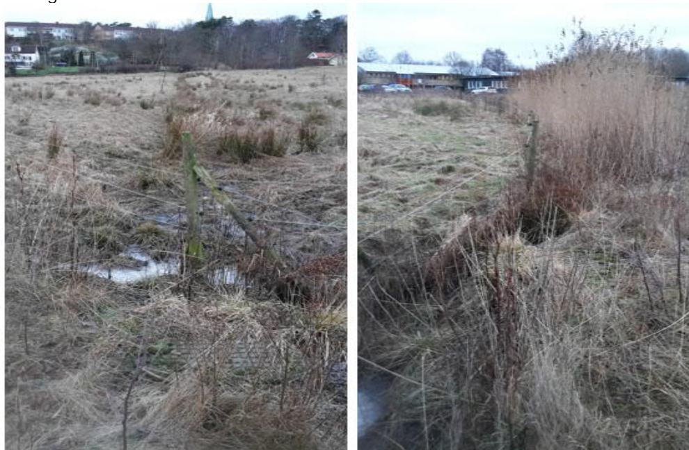
Figur 8. Dike inom område A som fördröjer dagvatten och leder dagvattnet till dagvattennätet.
