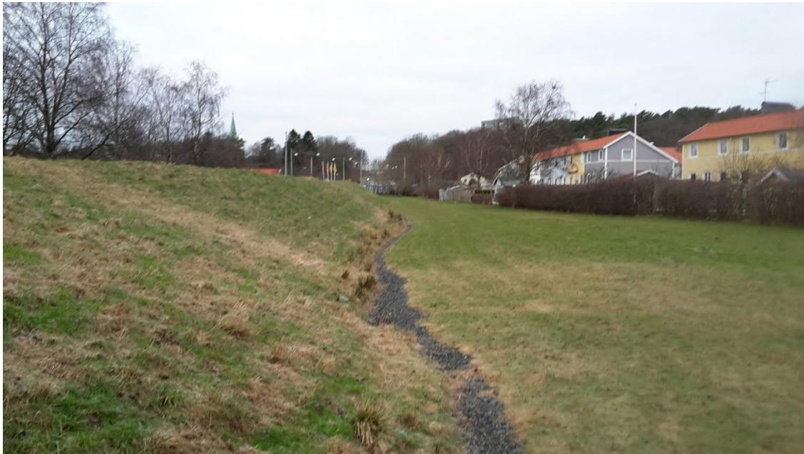
Figur 13. Makadamdike längs med bullervall i område C.
