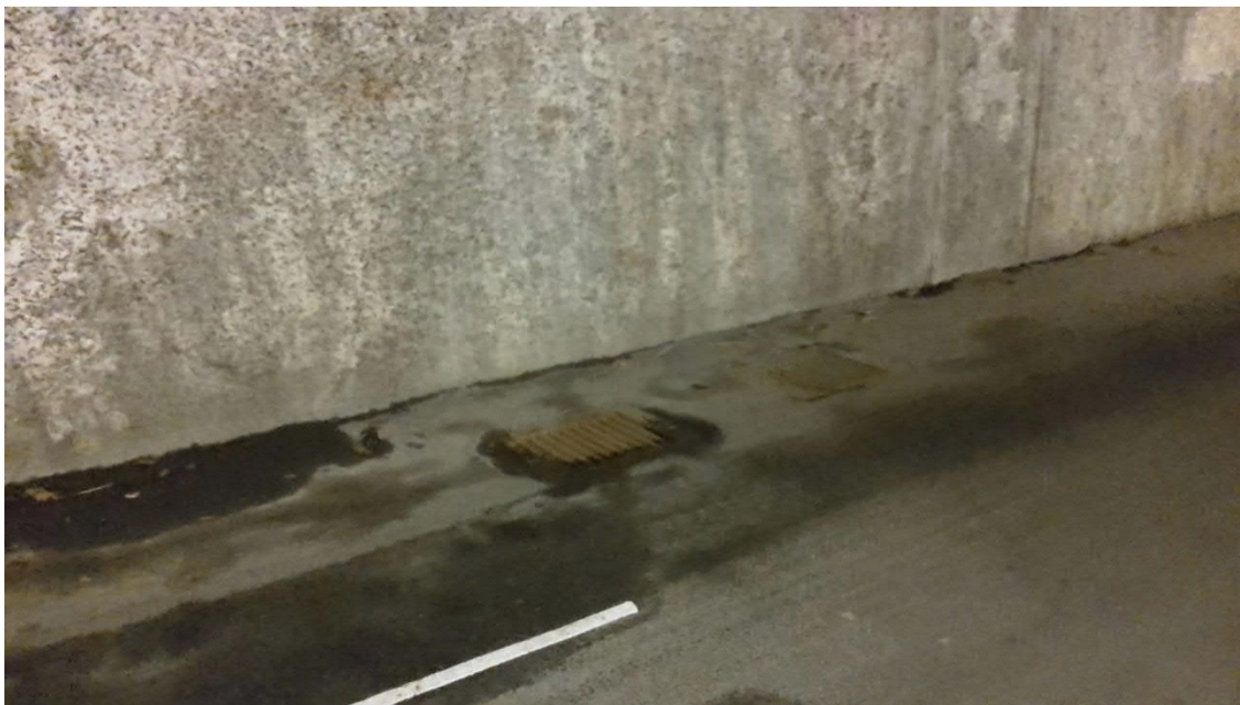
Figur 14. Dagvattenbrunn i GC-tunnel, sydväst om område A.
